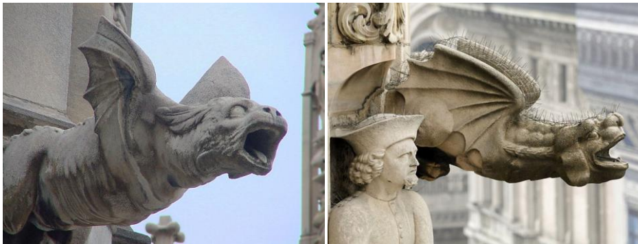
Due esempi di gargoyle, gli sgocciolatoi a forma di mostri a protezione di diverse chiese gotiche
